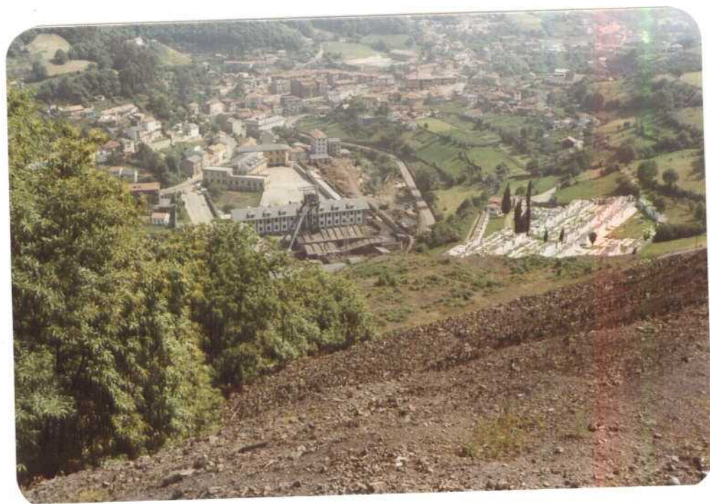
Vista del pozo San José desde la escombrera del mismo nombre.
