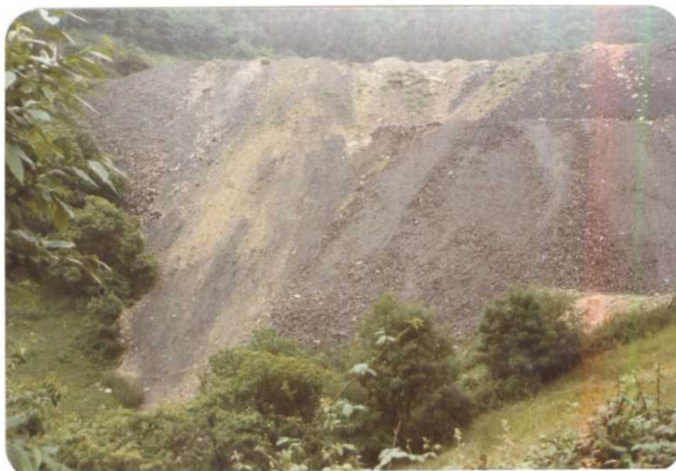
Escombrera con gran diversidad en el tamaño de los escombros.
