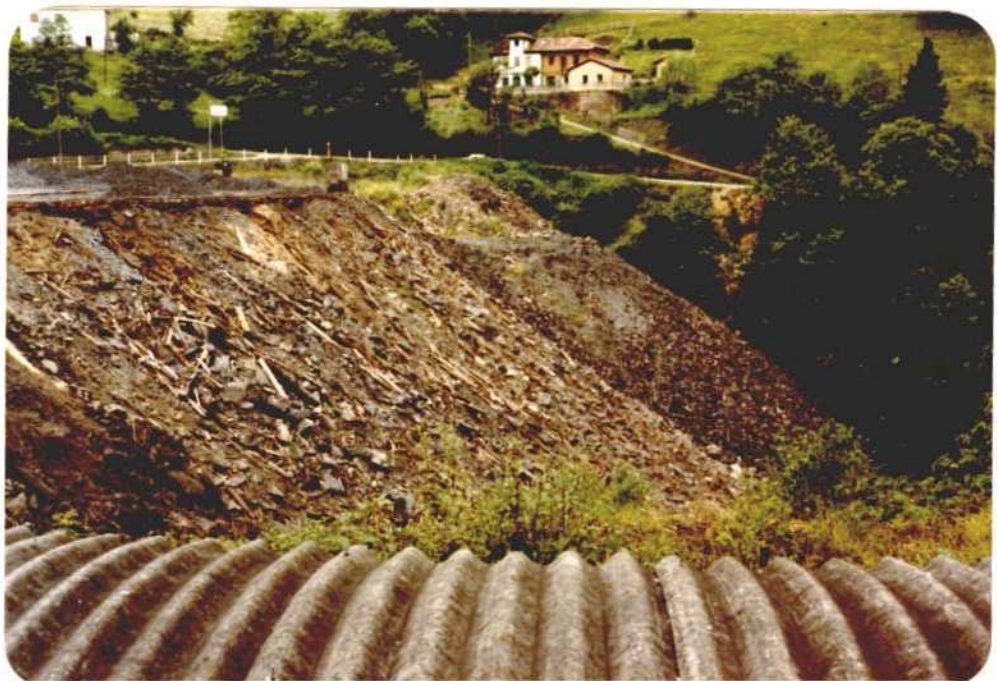
Vista general. Observese la heterogeneidad del material y el sistema de vertido.
