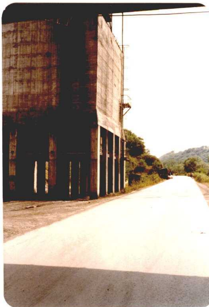
Acceso al lavadero por la carretera de la Felguera a Tuilla.
