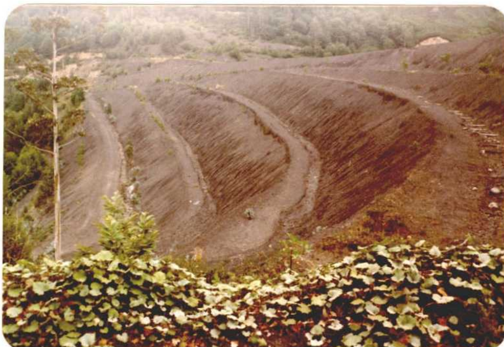
Vista lateral de la escombrera de Morgao. Observese la disposición en bermas.
