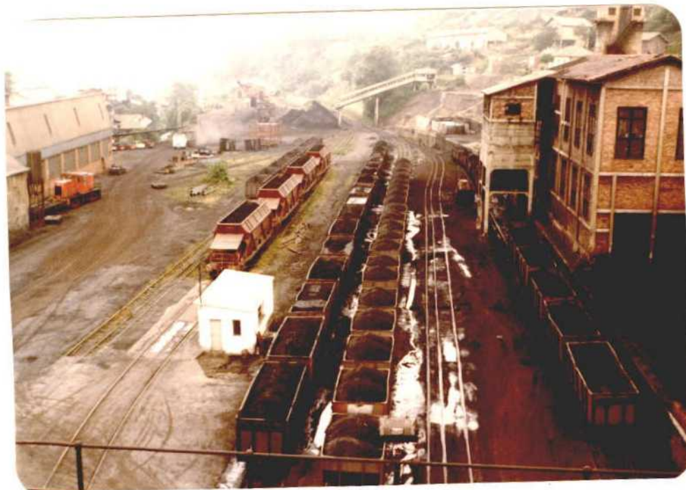
Acceso al lavadero por la Carretera de Figaredo a Urbíes.
