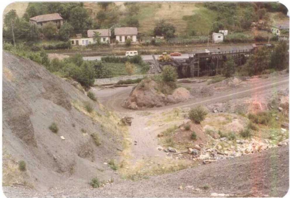
Acceso a la escombrera por la carretera de Figaredo a Urbies.
