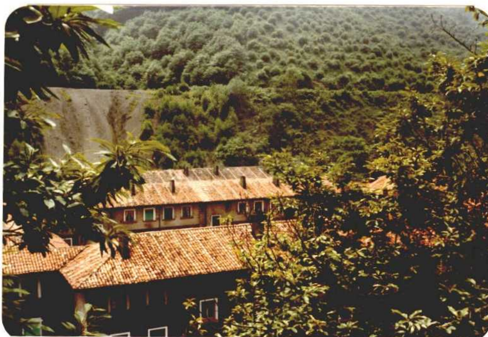
Vista general. Se encuentra parcialmente cubierta por la vegetación.
