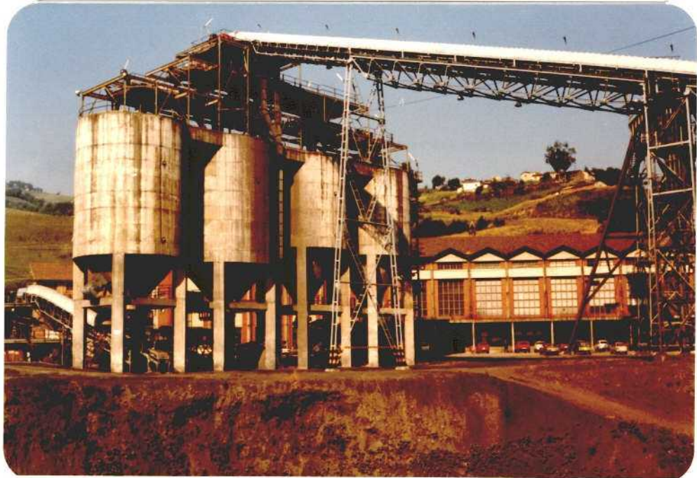
Tolvas de recogida del estéril y del mineral.
