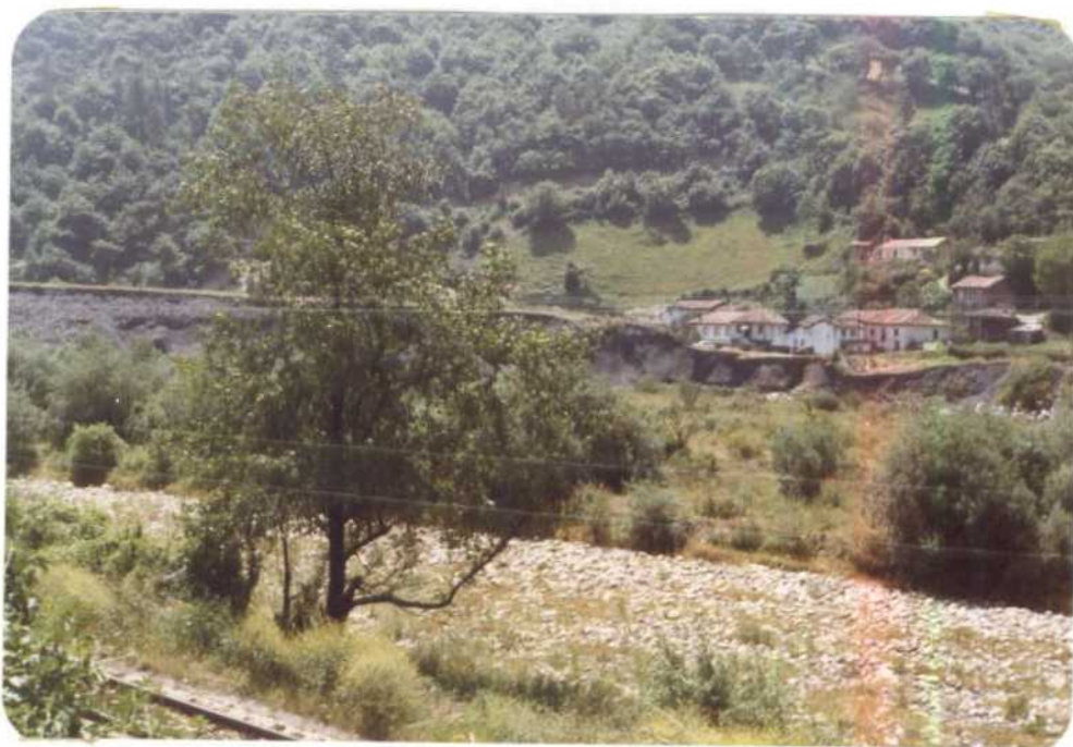
Vista parcial de la escombrera. Observese la erosión activa del pie, causada por el Rio Aller.
