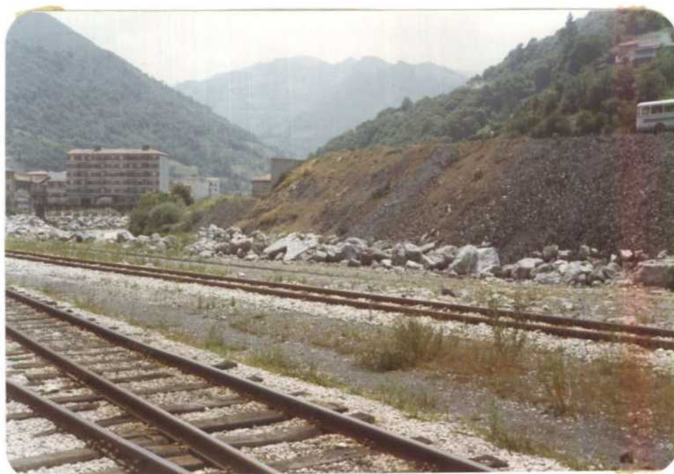
Vista parcial. La protección del pie de la escombrera es mediante bloques.
