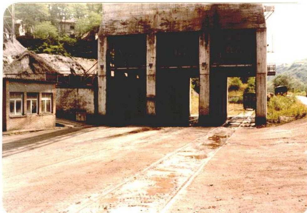
Tolvas de recogida del estéril para su posterior transporte a escombrera.
