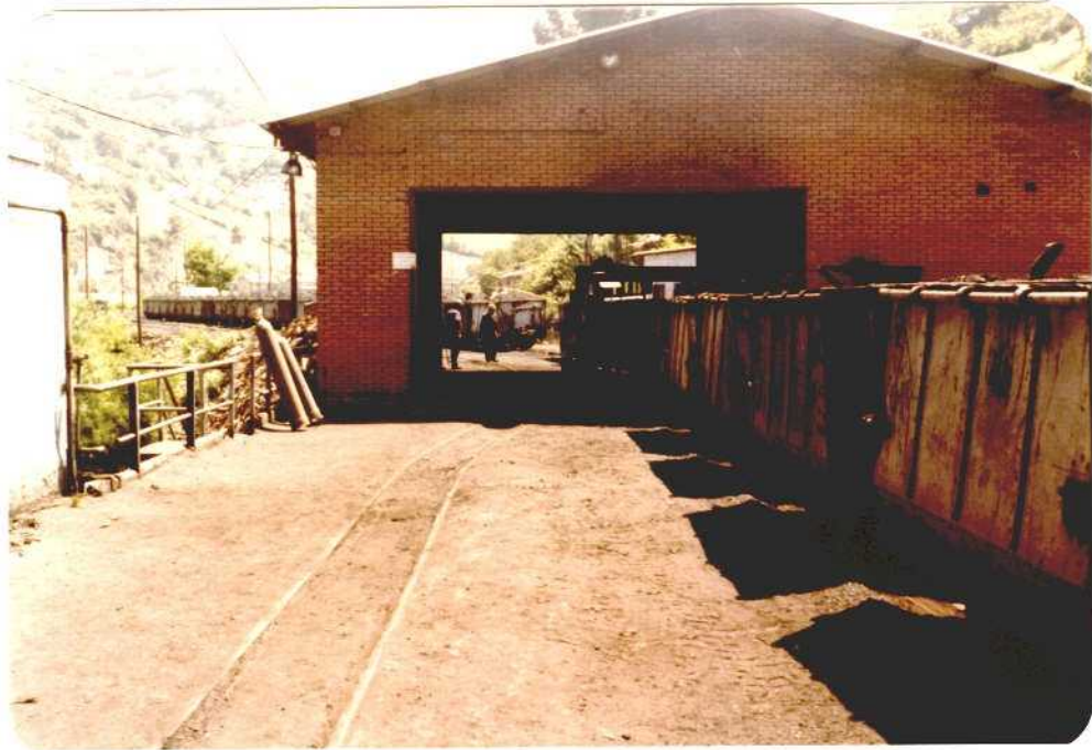
Accesos al lavadero de Sovilla. Al fondo la Carretera Nacional a Oviedo 630.
